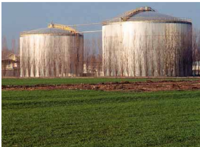
1 - Impianto centralizzato di biogas di Spilamberto (MO) in primo piano i due digestori anaerobici. 2 - Stoccaggio di sfalci verdi in un impianto centralizzato per la codigestione di liquami suini, scarti agroindustriali e sfalci verdi per la produzione di biogas
